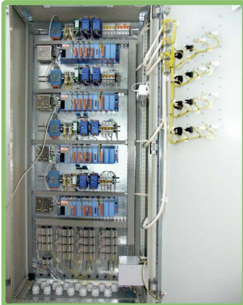
Конструктивное исполнение – стальной шкаф фирмы RITTAL, с габаритами 800×2200×500 мм или 1200×2200×500 мм, соответствующий степени защиты до IP54.
